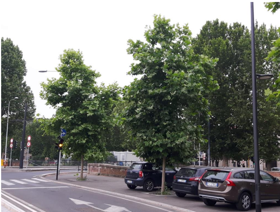
Figura 3 - Platani pronto effetto messi a dimora in Viale Milton in occasione dei lavori per la realizzazione della Linea 3.1
