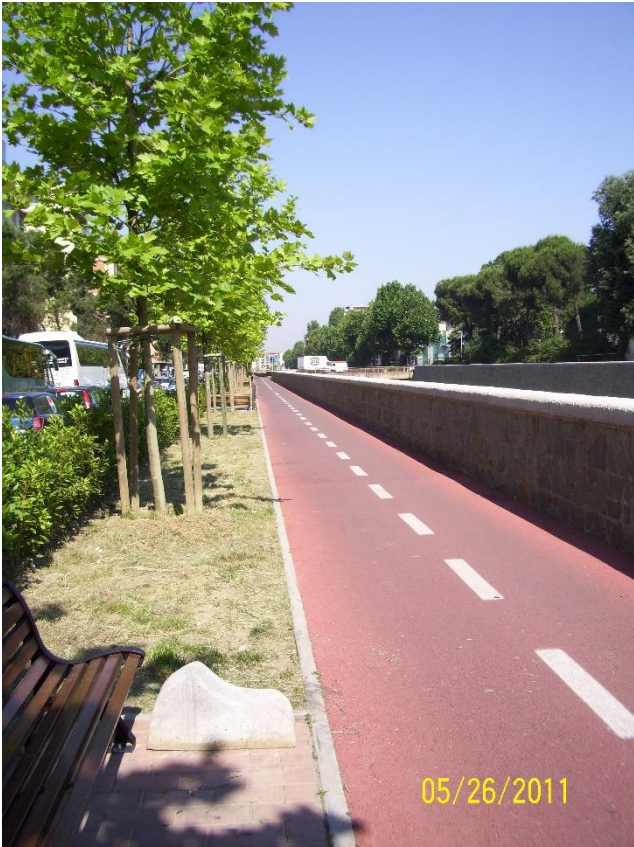
Lavori RFI - Viale Redi maggio 2011
