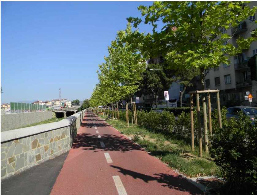
Lavori RFI - Viale Redi giugno 2011
